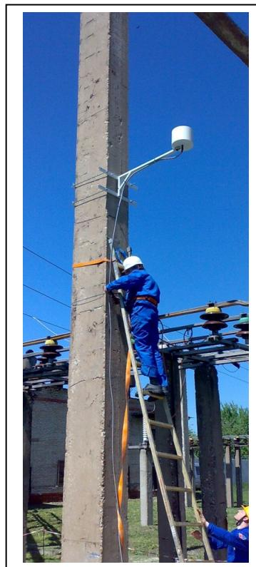
импульсов. Эта разница во времени прихода импульсов к различным СВЧ антеннам возникает из-за разного удаления приемных антенн от дефектного оборудования.
