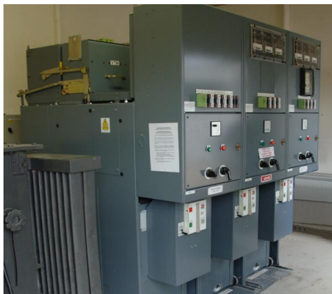
Рисунок 4: Вид спереди панелей № 1, № 2 и № 3 GEC VMX AIS (слева направо)
