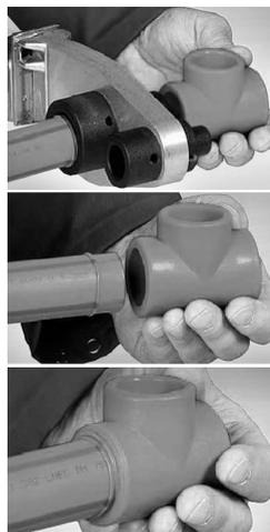
5 Аккуратно извлеките трубу и фитинг из сварочного аппарата и вставьте трубу в фитинг. При стыковке не рекомендуется вращать их относительно друг-друга. Для обеспечения необходимой точности (угловые фитинги) рекомендуется воспользоваться дополнительной оснасткой.
