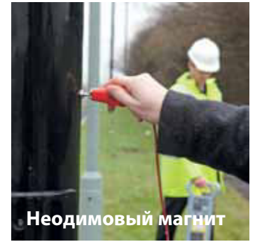
Способ трассировки кабелей малого диаметра
