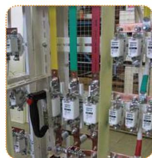
Шины дополнительно защищены термоусадочными трубками
