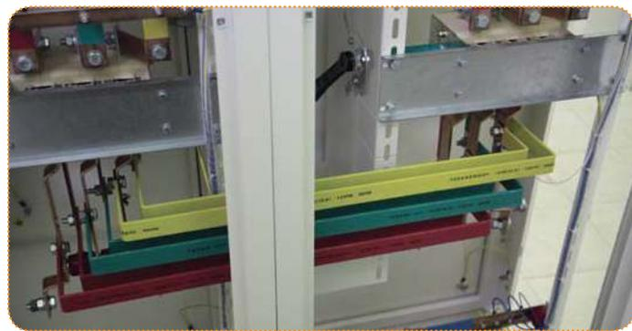
Соединения перекидных рубильников между собой, на вводных панелях, выполнены медными шинами
