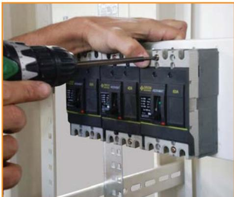
*Рис. 3. На них закрепляем автоматические выключатели*
