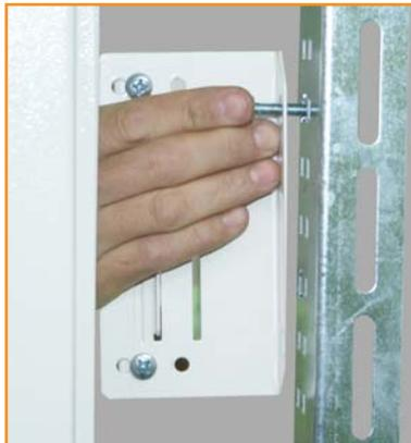
*Рис. 2. К ним винтами крепим монтажные платы*
