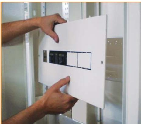
*Рис. 4. После разводки проводами, закрываем пластрами*
