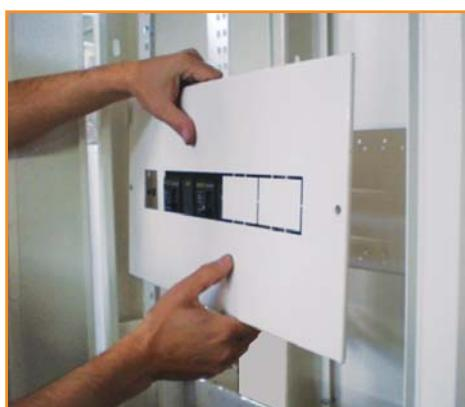
Рис. 4. После разводки проводами, закрываем пластронами
