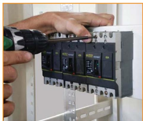
Рис. 3. На них закрепляем автоматические выключатели
