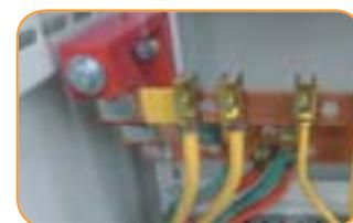
Изоляторы шинные «Лесенка» используются при сборке НКУ различного назначения
