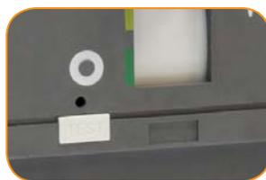
Проверка работоспособности автоматического выключателя кнопкой «ТЕСТ»
