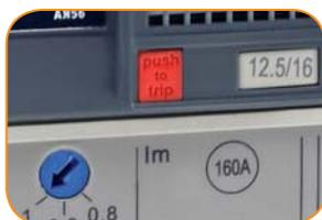
Проверка работоспособности автоматического выключателя кнопкой «тест» (Push to trip)
